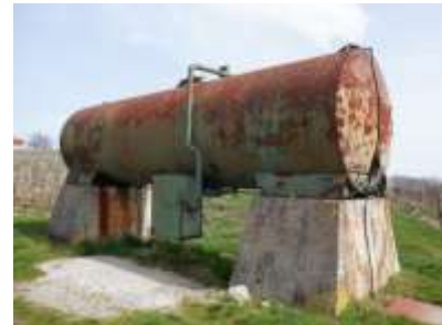
stara cisterna za vodo
